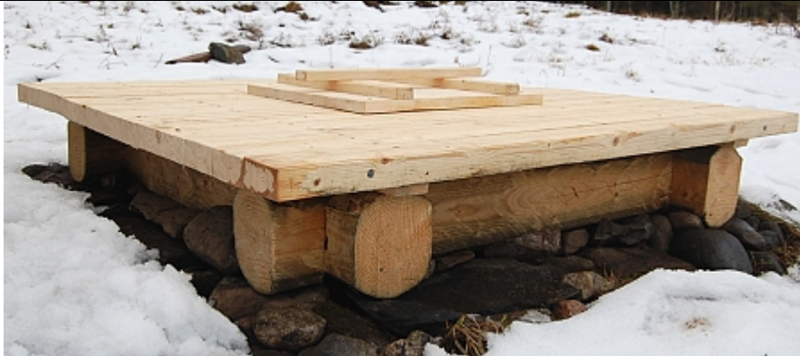
Punkaharjun kotiseutumuseolla v. 2014 valmistunut saunakaivon kansi ja yksikerroksinen kehä , joka tehtiin yleiskirveellä pelkatusta kuusesta ylä- ja alaloveusnurkalla.
